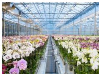
Automatización de invernadero
