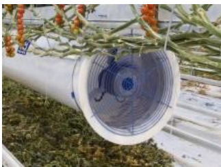
Tratamiento de Aire Priva
