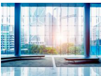
Automatisation des bâtiments
